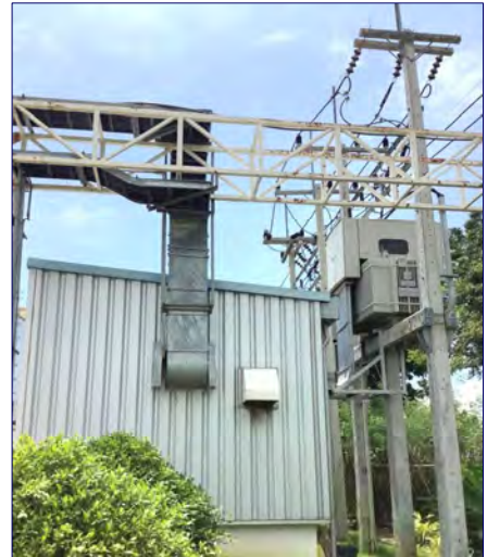
ภาพแสดงนั่งร้านหม้อแปลงบนเสาไฟฟ้าแรงสูง
